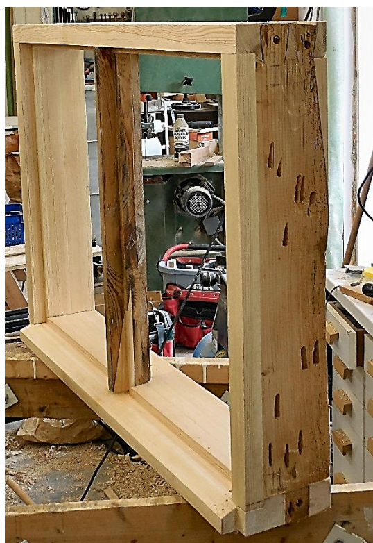
Fönsterkarmarna krävde omfattande reparation. Befintligt virke behölls till en mindre del. Foto Göran Ulvfot, Båt & byggnadsvård i Roslagen
