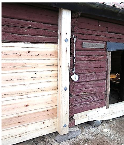
Bilden ovan visar ny väggsektion, följare och syll med tröskel.
