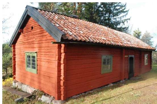
Hammarbystugans nyrenoverade exteriör. Fotografier Rolf Hammarskiöld 2017-11-03
