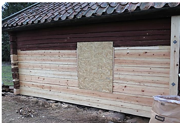
Bilden ovan togs då den väggsektionen var helt klar. Till höger ses en ny följare. Foto Sara Borgesjö 2015-12-11
