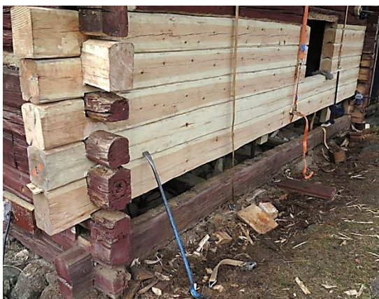
Bilden ovan togs då ny väggsektion i nordost sattes in. Foto Sara Borgesjö 2015-11-13
