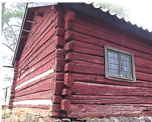
Bilden ovan visar ny väggsektion, följare och syll med tröskel.
