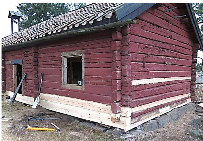
I östra långsidans norra del byttes två syllvarv. På norra gaveln räckte att halvsula tre befintliga stockar.
