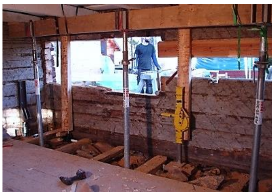
För att kunna byta väggtimmer avlastades den bärande väggen med stämper. Foto Söderbykarls fornminnes- och hembygdsförening 2015.
