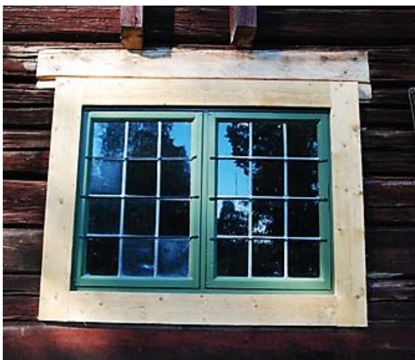
De nyrenoverade fönstren fick foder med sågad yta. Foto Hanna Hjalmarsson 2016-09-07
