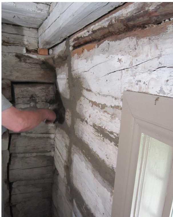
Bilden till vänster togs den 7/5–2018, då lerkliningen kompletterades mellan kammarväggarnas plant bilade stockar. Bilden till höger togs den 9/7–2018, då kammarens renovering hade avslutats. Fotografier Rolf Hammarskiöld
